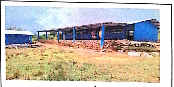
Foto 6: Observándose los diferentes procesos realizados en la cocina, cambio de laminas troqueladas e instalación de costaneras.
