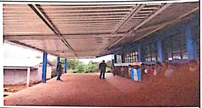
Foto 2: vista Frontal del establecimiento, cambios de costaneras y laminas troqueladas del corredor
